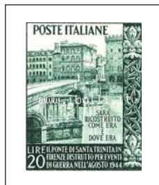
Ponte a Santa Trinità
